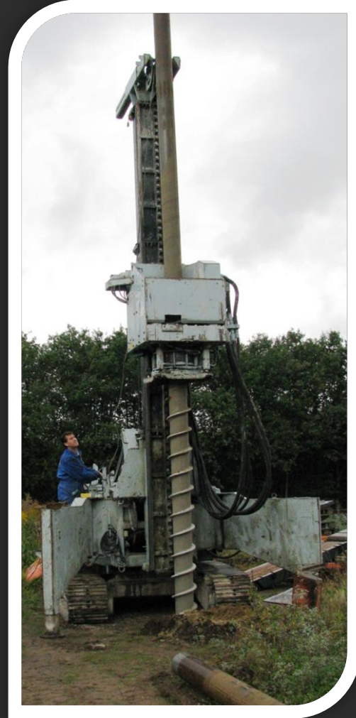
Figuur 2 installatie CP-Pile
